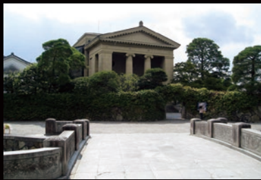
大原美術館 岡山県倉敷市
